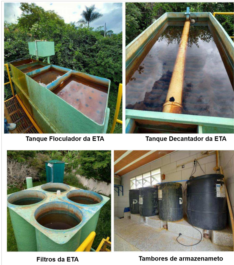
Figura 16 - Estruturas físicas do processo de tratamento
