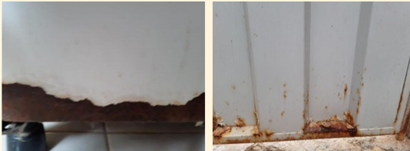
Figura 2 - Patologia causada por corrosão: (a) base de fogão; (b) base de portão
