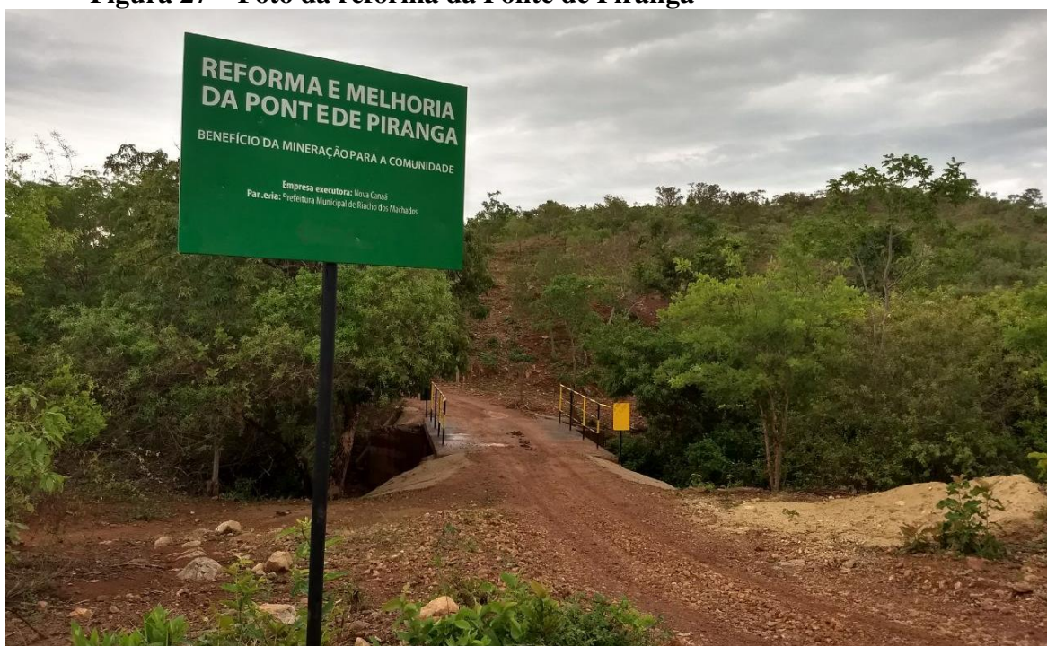
Figura 27 – Foto da reforma da Ponte de Piranga
