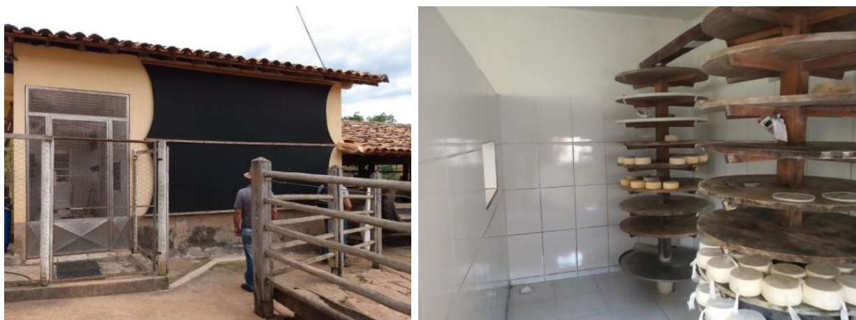
A= Parede externa e cobertura. B= Vista interna da sala de maturação (Fonte: Arquivo Pessoal, 2019).
