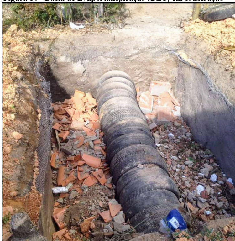
Figura 10 - Bacia de Evapotranspiração (BET) em construção
