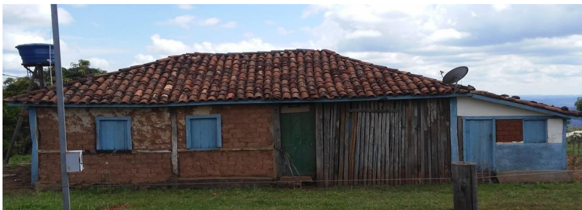
FIGURA 10 – casa rural construída com adobe, Povoado de Campo da Dona – Diamantina/MG, 2019
