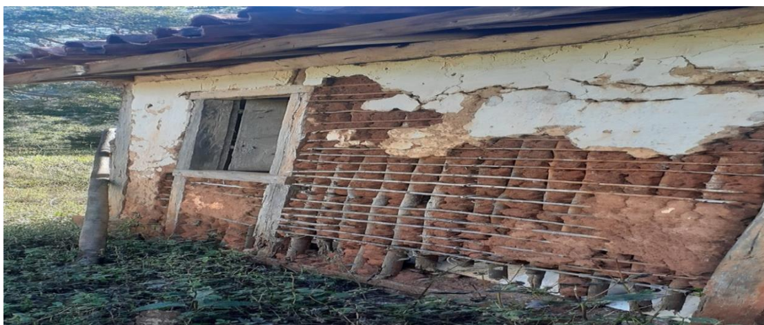
FIGURA 9 – Casa rural construída no pau a pique, Sítio Boa Vista – Diamantina/MG, 2020
