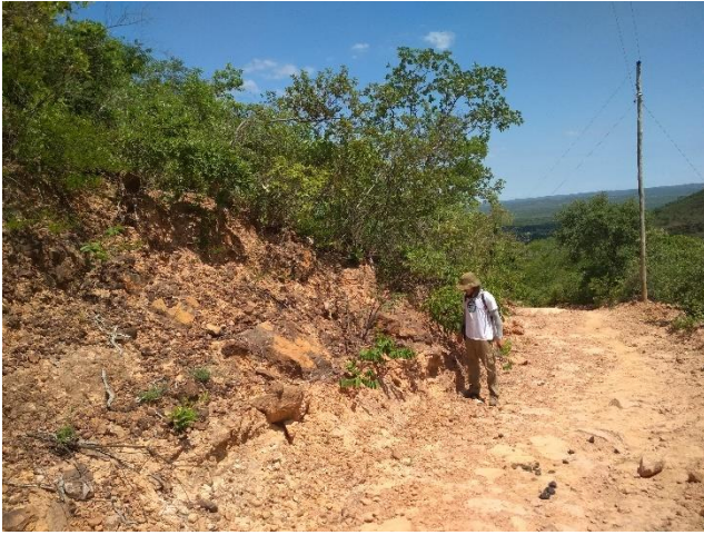
Tilitos (barranco) capeando metassiltitos (leito da estrada).
