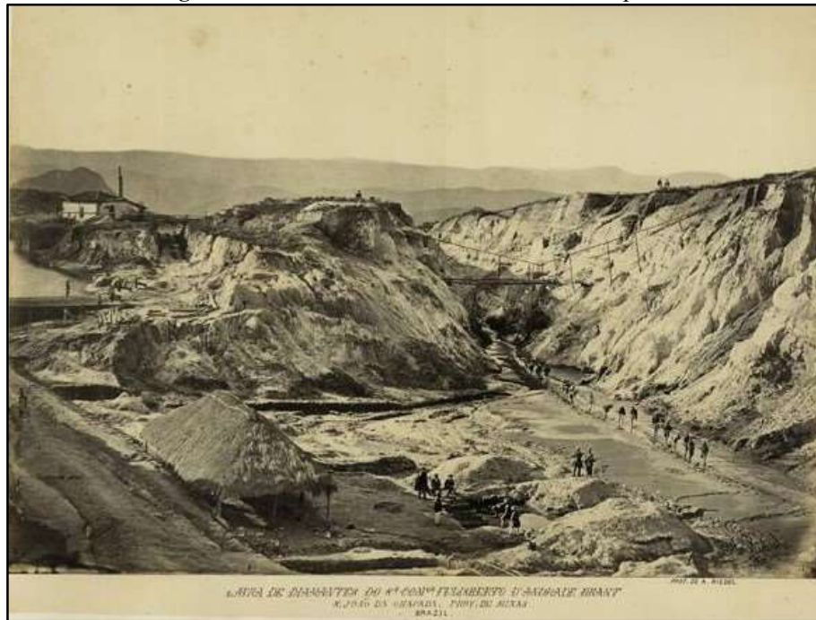
Figura 15 - Mina do Barro, em São João da Chapada.
