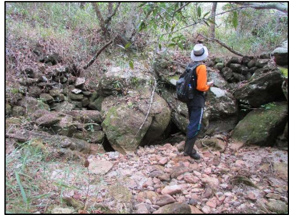
Figura 31 - Área de barragem.
