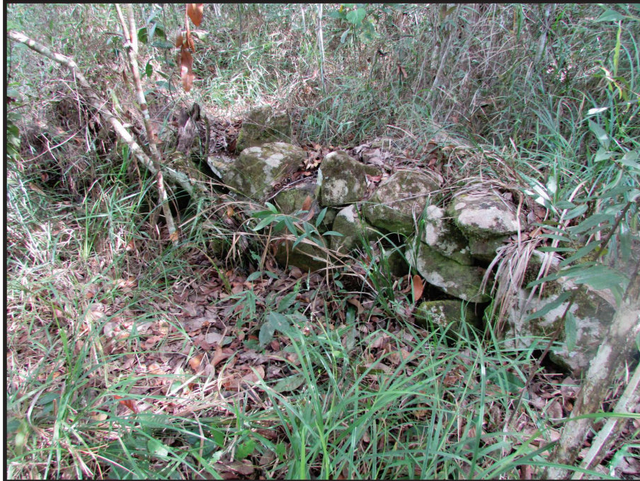
Figura 59 - Visada Canal CNII.
