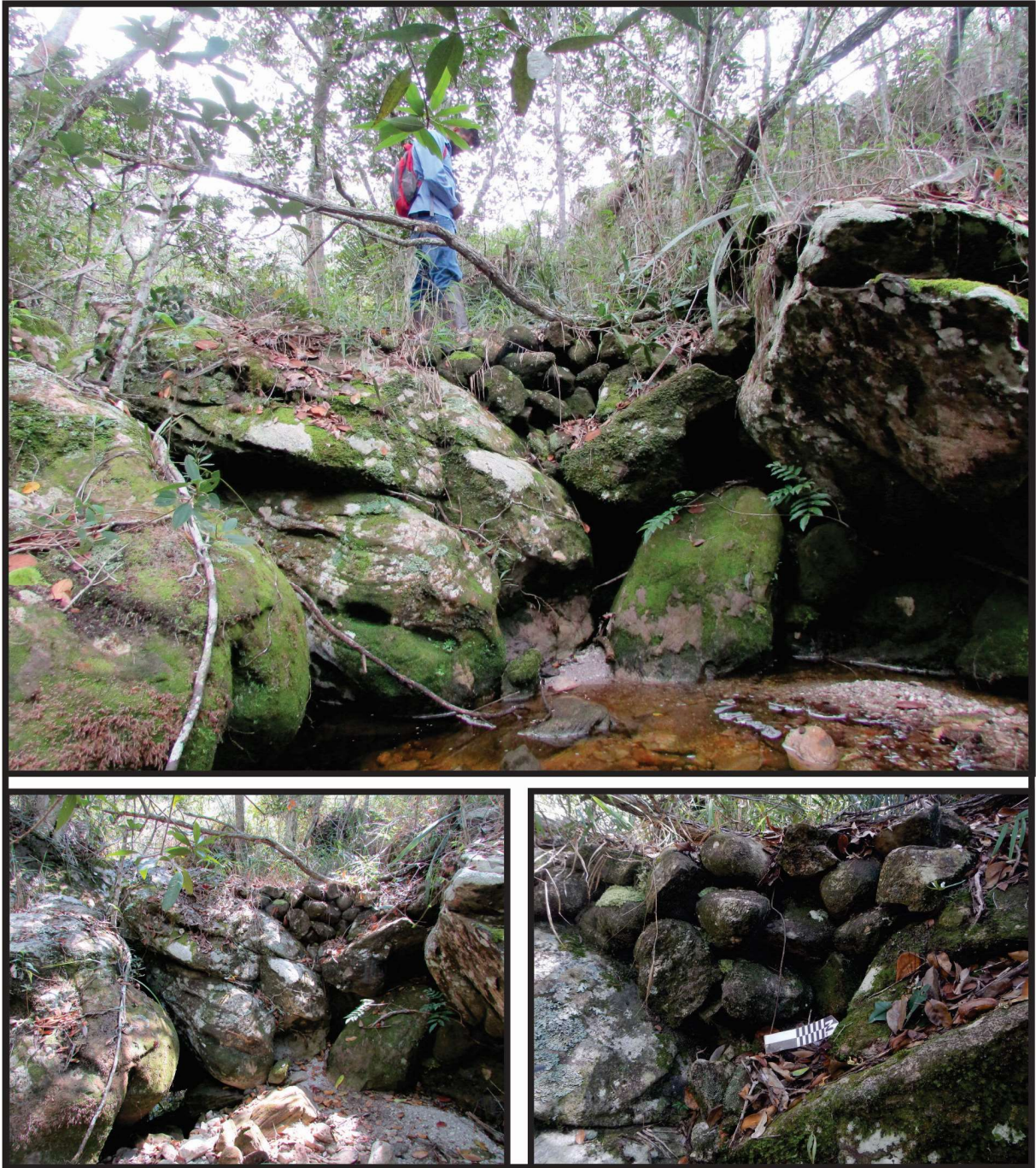
Figura 67 - Visada Barragem I.
