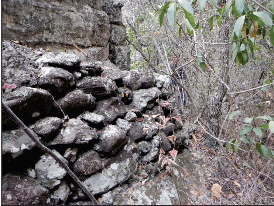
Figura 70 - Visada estrutura MRV.
