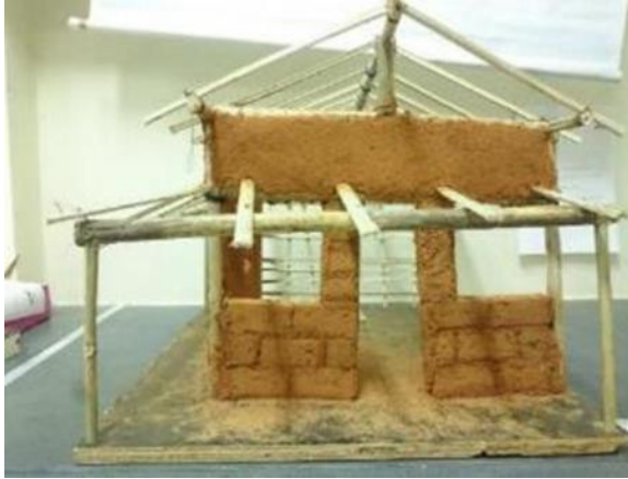
Revestimento do trançado com barro
