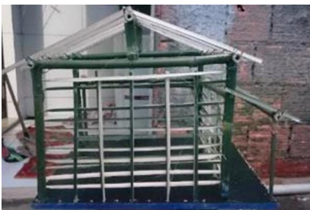
Montagem do entrelaçado de bambu
