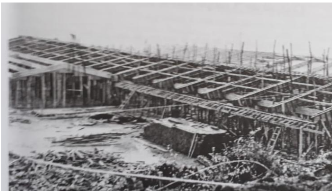
Figura 4 – Foto da Construção da E.E.J.A.F.
