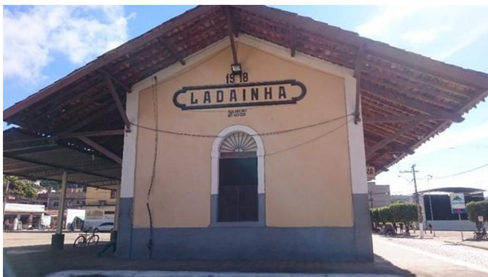
Figura 1 – Antiga sede da Estação de Ferro Bahia e Minas em Ladainha
