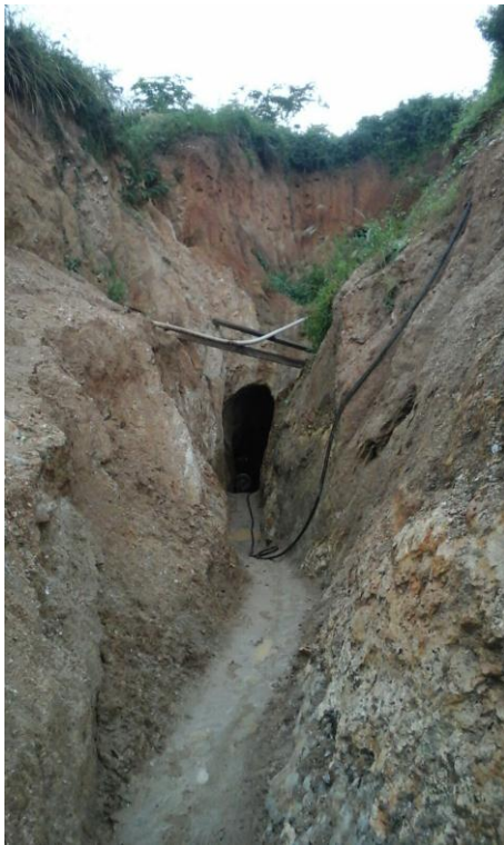
Figura 11 – Escavação de um túnel no leito seco de um rio Fonte: Repositório digital da autora
