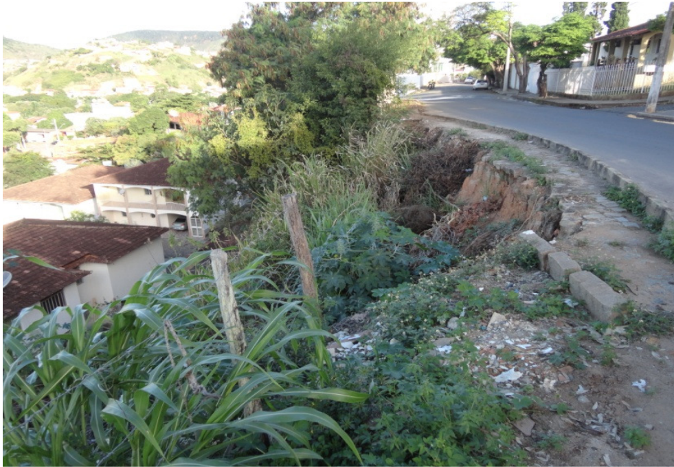
Figura 21 – Fotografia de Voçoroca na Região Central da Cidade na Rua Ana Amália (GOMES, 2013).
