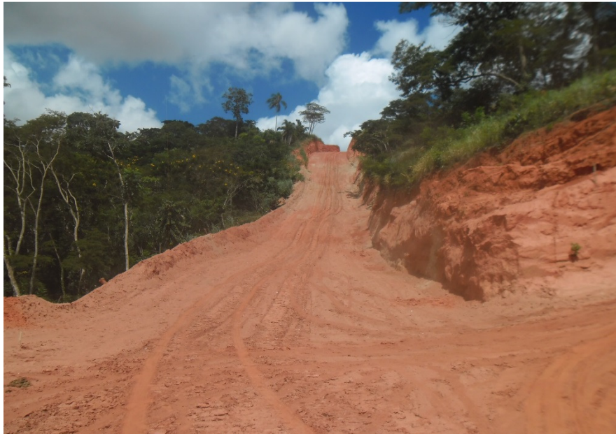
Figura 11 – Fotografia de Intervenção Ilegal em Área de Preservação Permanente em Loteamento Embargado no Bairro Laranjeiras (SEMAD, 2015 - Arquivo Institucional).
