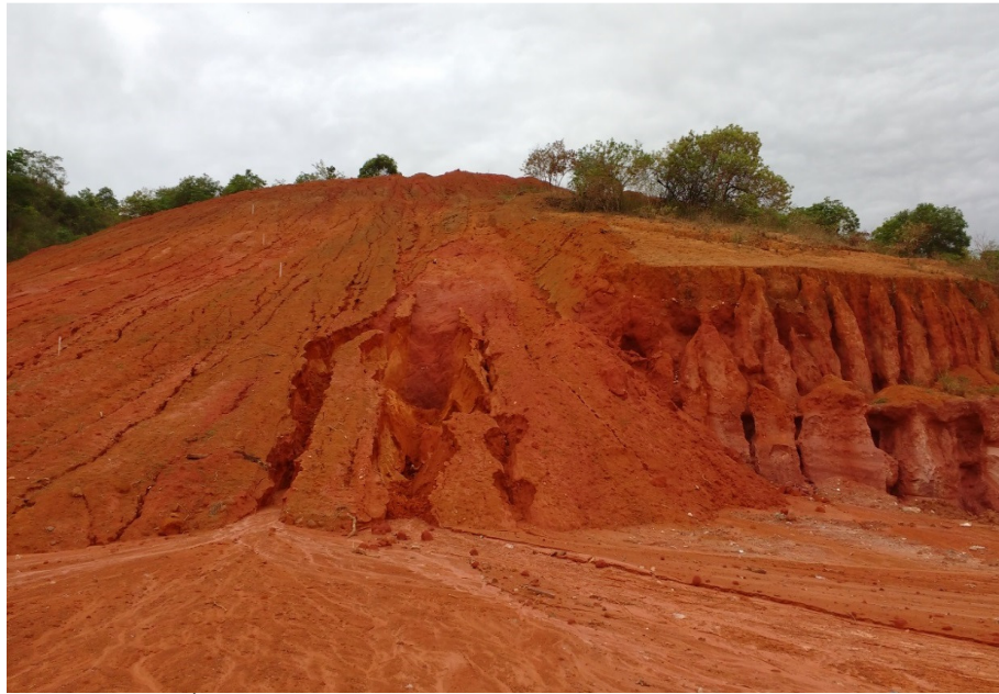
Figura 15 – Fotografia de Área de Instabilidade do Solo Ocasionada pela Supressão da Vegetação no Bairro Esmeraldas (Arquivo Pessoal, 2016).
