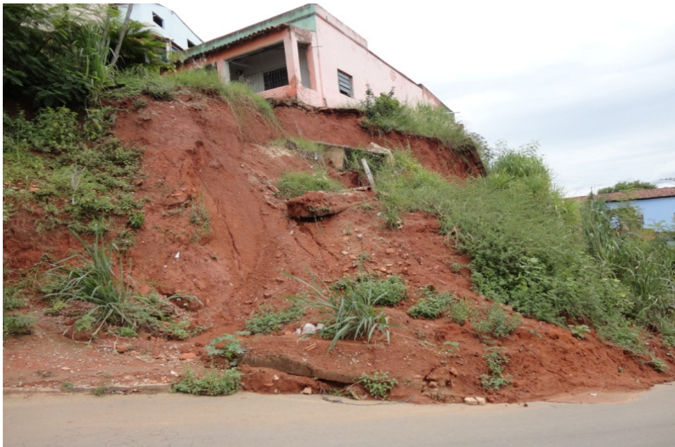
Figura 22 – Fotografia de Construção em Área de Intenso Risco Geológico com Movimento de Massa nas proximidades da Rua Marcelo Guedes (GOMES, 2013).
